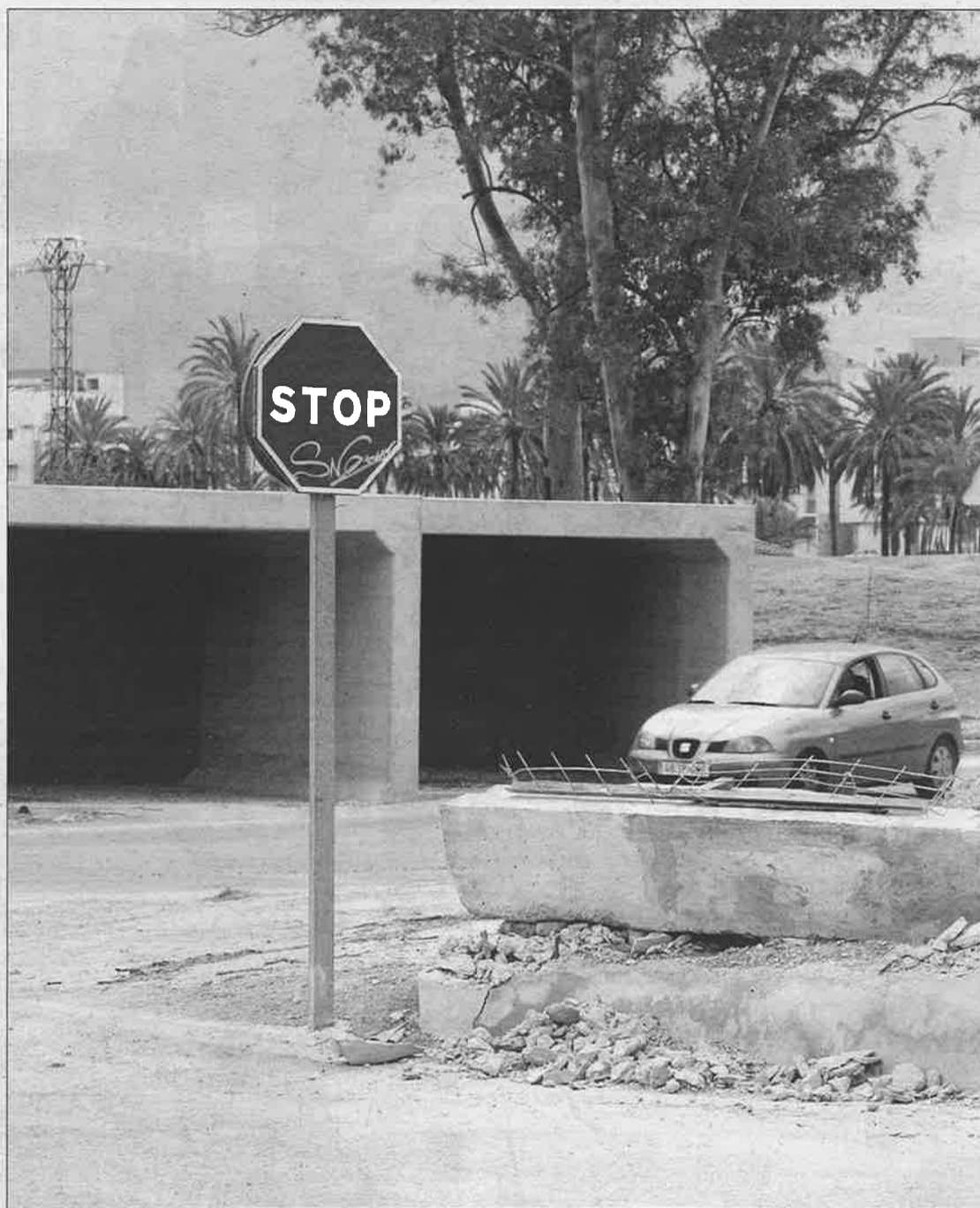
En la rambla del Puerto ya están colocando los primeros elementos de contención. JUAN CABALLERO
