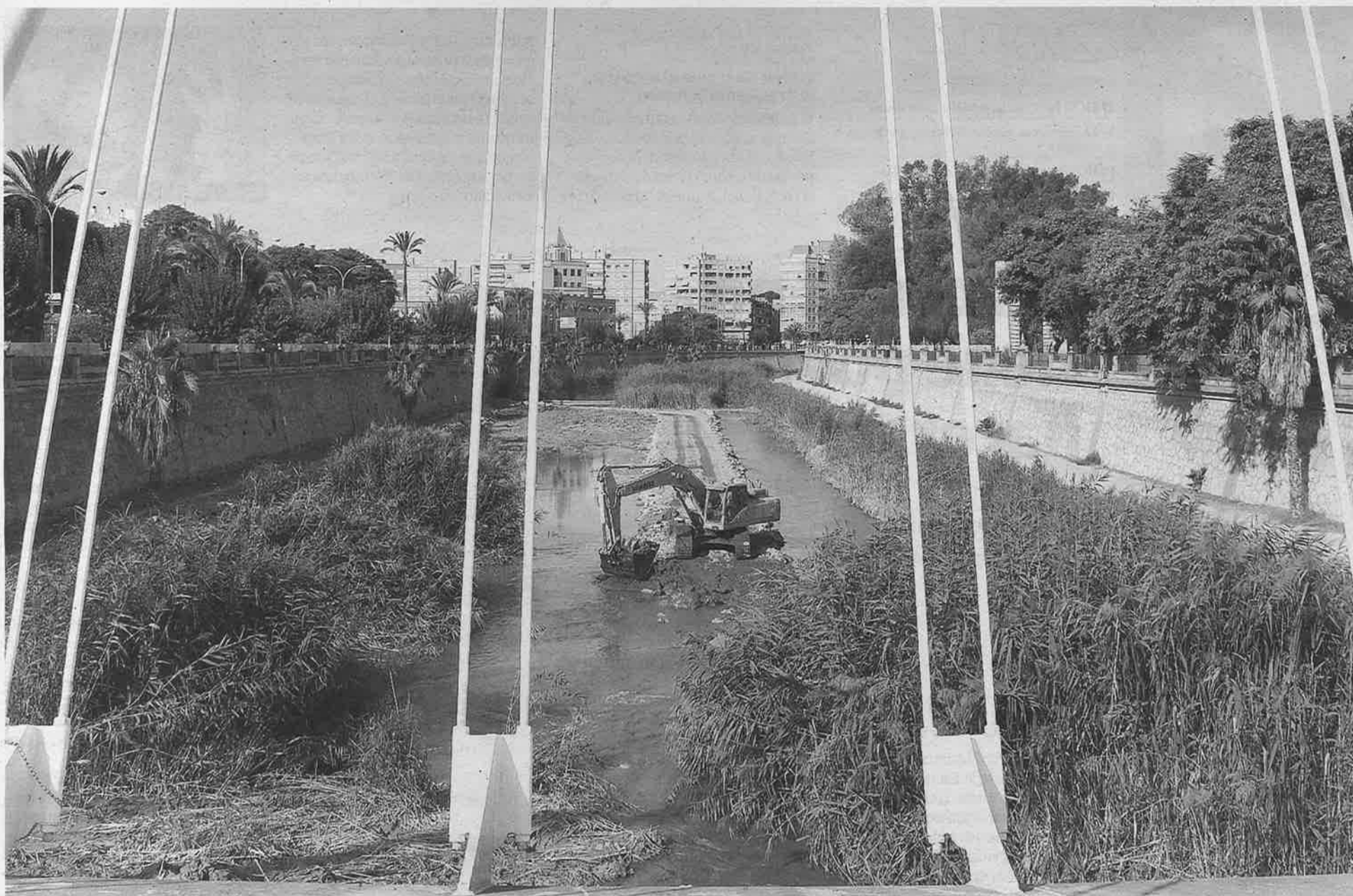
Trabajos de dragado que se llevan a cabo frente al hospital Reina Sofía. La pala retroexcavadora extrae sedimentos del lecho del río. :: FRAN MANZANERA/AGM
