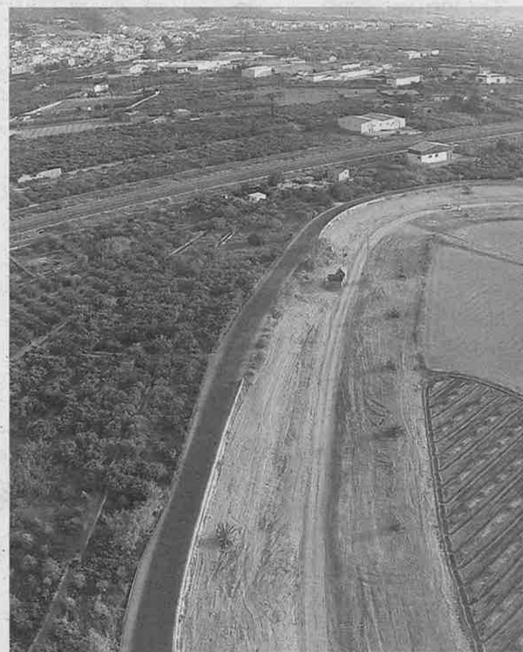
Soto ya compactado en Llano de Brujas, frente a la depuradora.
